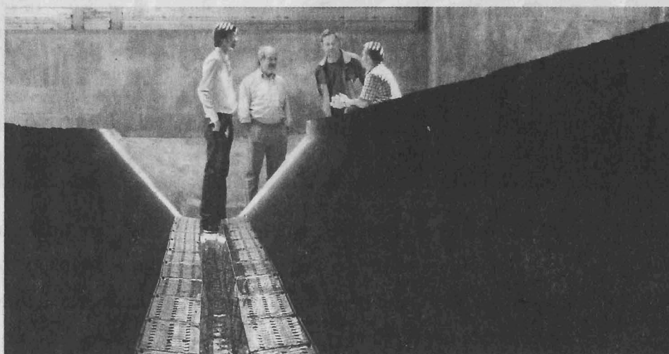
Der Ingenieur Jan Butz (li.) besichtigt den Kanal mit den Wärmetauschern.
