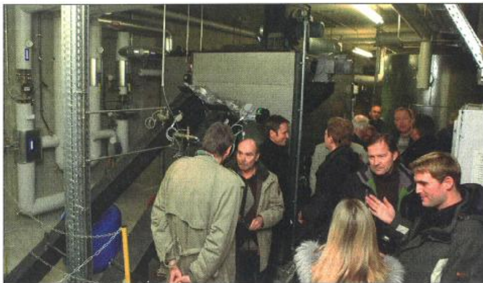
Gemeinderäte, Ingenieure, Rathausmitarbeiter in der Hungerberg-Heizzentrale.
