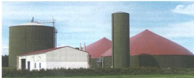
Ganzjährige Nutzung über Nahwärmenetz: Die Biogasanlage in Buchloe-Nord versorgt Winter wie Sommer eine Großschlachtereier mit Wärme. Möglich wird dies unter anderem durch einen 200-Kubikmeter-Pufferspeicher (grüner Turm im Vordergrund). Fotos: Dany
